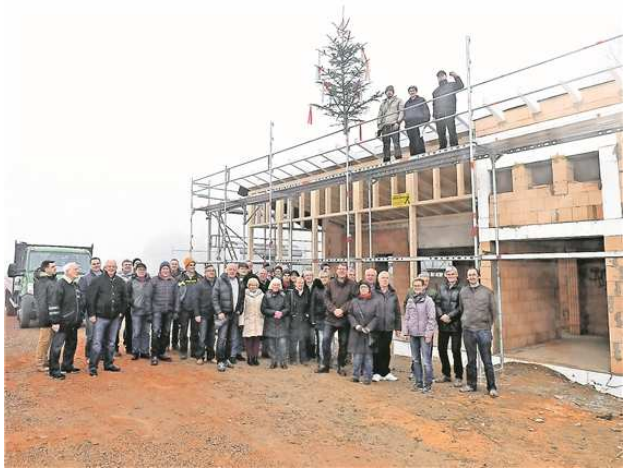
Bürgermeister, Gemeinderäte, Planer und Handwerker sowie zahlreiche Vereinsmitglieder kamen gerne zum Richtfest der zügig erstellten Vereinsanlage. Den Richtspruch zelebrierten auf dem Gerüst Rainer Prokosch, Barbara Prokosch und John Wallace (von rechts). Foto: Manfred Schott
